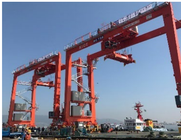
写真 神戸港の水素燃料電池換装型 RTG
