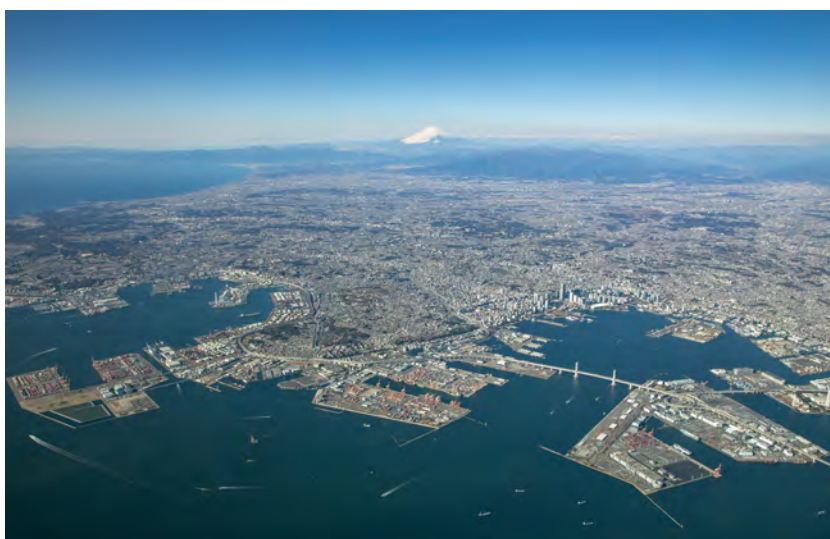
横浜港全景 写真提供 横浜港埠頭株式会社
