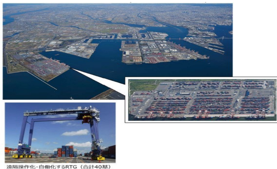
図 5.3.5 鍋田ふ頭コンテナターミナル
