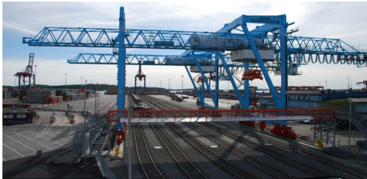
① コンテナターミナルへの引込線 クレーン2基新設 線路5本→6本に増設
