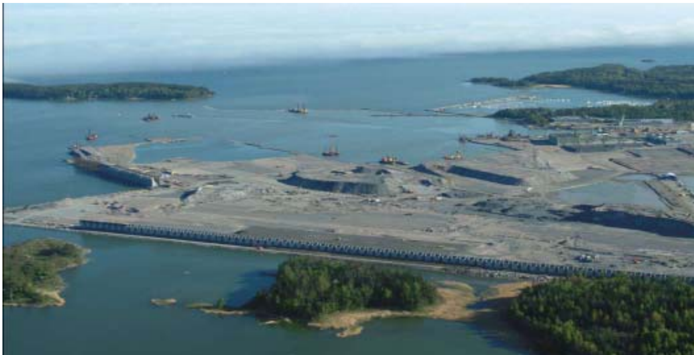
ヘルシンキの新ヴァーサリ港には巨大な防音壁が設置されている
