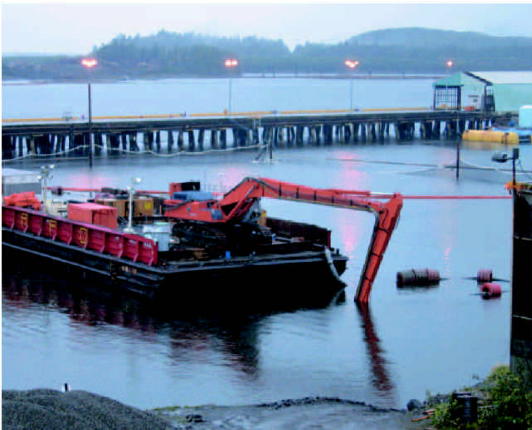
写真 :プリンスルパート港での浚渫工事
