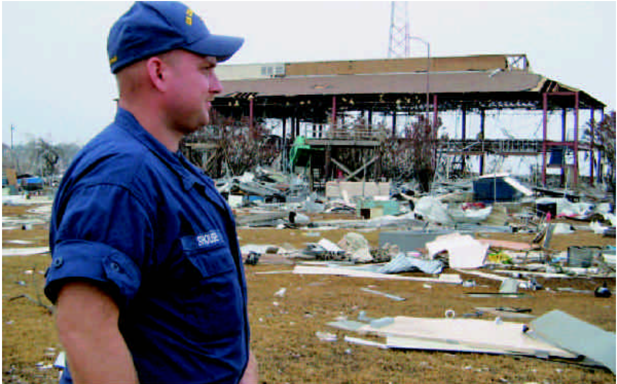
写真：廃墟 カトリ ナ襲撃まで沿岸警備隊基地として使われていた残骸を再調査する沿岸警備隊員
