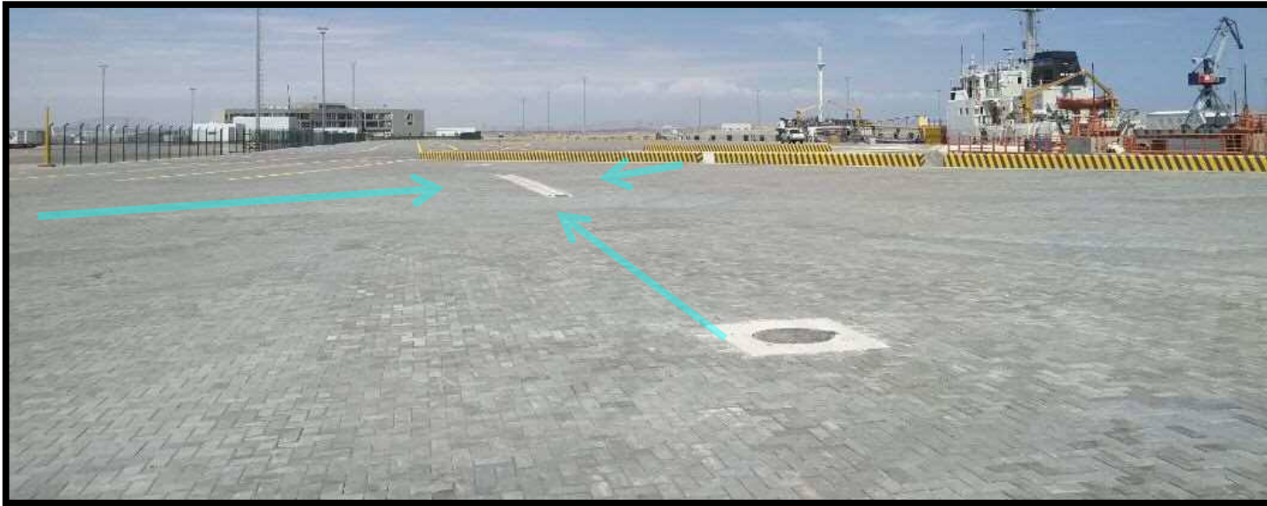
ヤード内舗装
