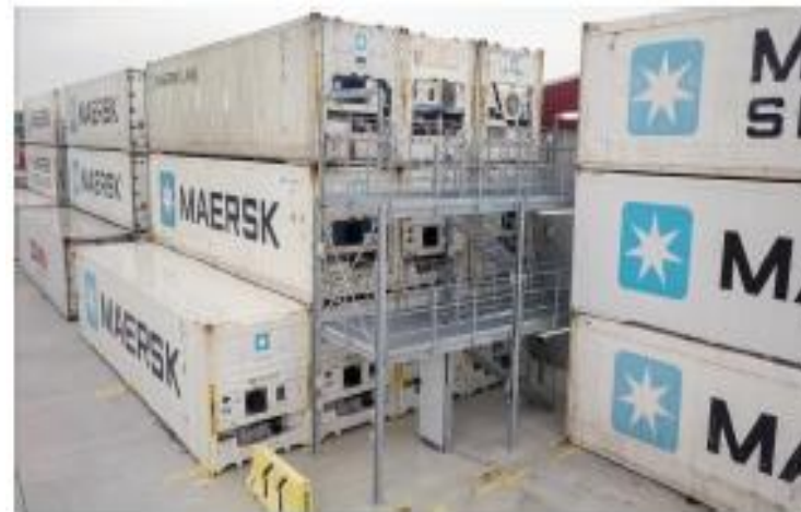
生鮮食品のための冷凍コンテナ蔵置場（60台）
