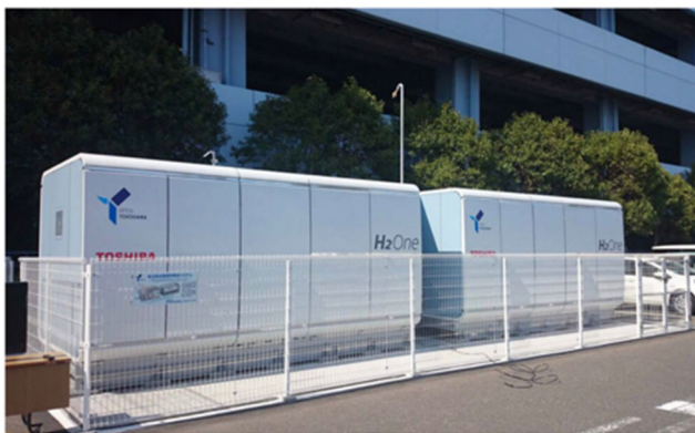
図 5-1 官公庁で初めて導入した自立型水素燃料電池システム（大黒ふ頭・横浜港流通センター）
