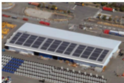
図 5-6(左) 太陽光発電設備の導入 出典：横浜市港湾局及び横浜港埠頭株式会社資料 図 5-7(右) 省エネプロペラの導入 出典：商船三井テクノトレード株式会社ホームページ
