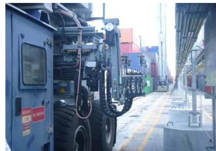
写真 3 RTG 集電装置とバスバー※
