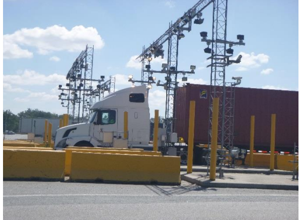
写真 5 ゲート直前に設置してある OCR (現地にて撮影 [17/9/26])
