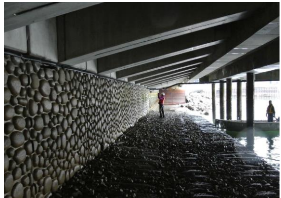
護岸の壁面には凹凸をつけ貝や藻が繁殖しやすい構造
