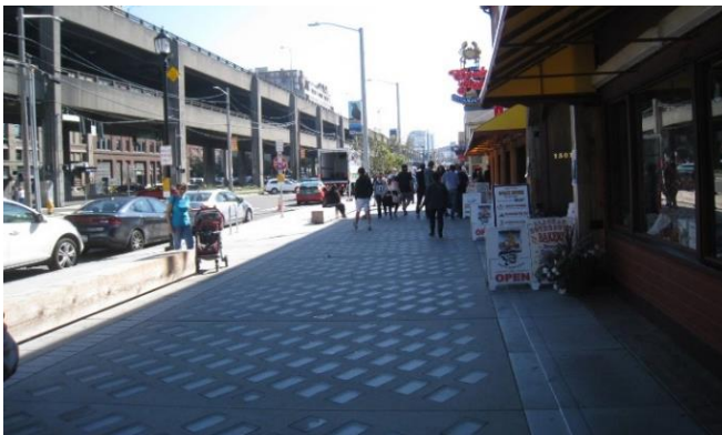
改修後の護岸（上部はプロムナード）
