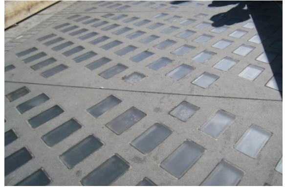
透過性のあるガラスブロック
