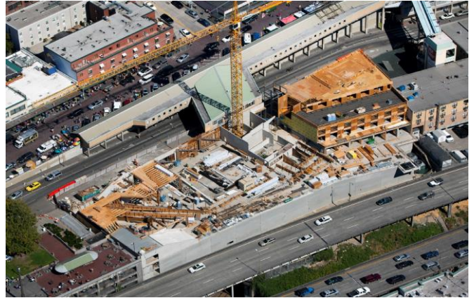
商業施設の建築工事中
