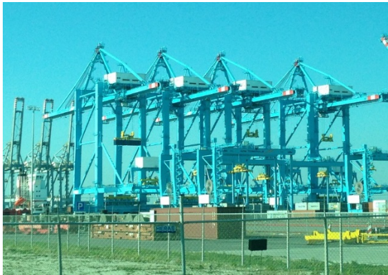
ガントリークレーン
