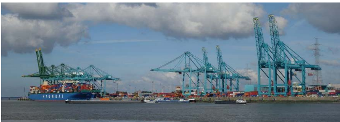
ノルドジー・ターミナル
