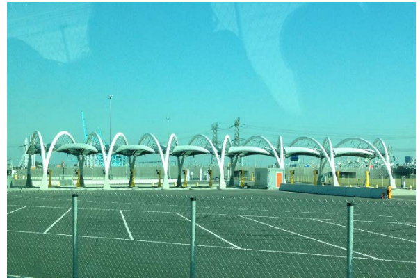
コンテナターミナルゲート
