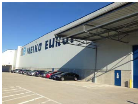
(写真 5) GDC 外観
