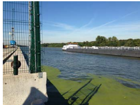
(写真 4) 運河を行き交うバージの様子
