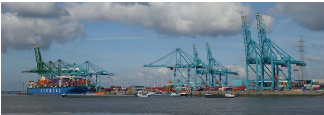
ノルドジー・ターミナル
