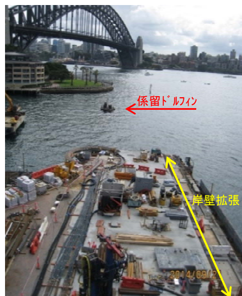
写真. 3-8 工事中の岸壁拡張部 (2014. 9. 21 撮影)
