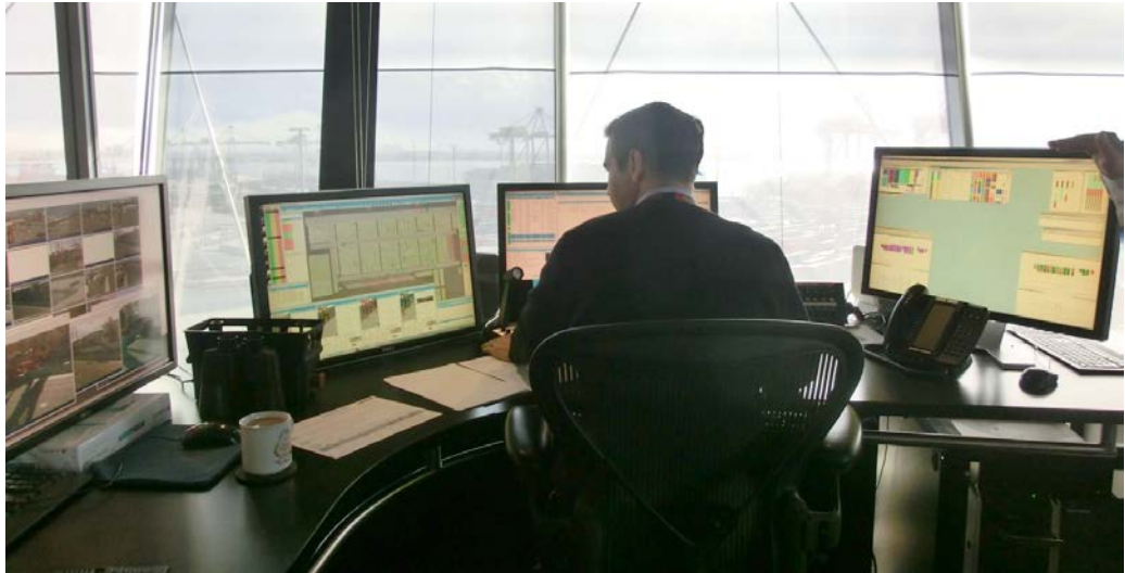
(写真—8) 交通制御システム監視室
