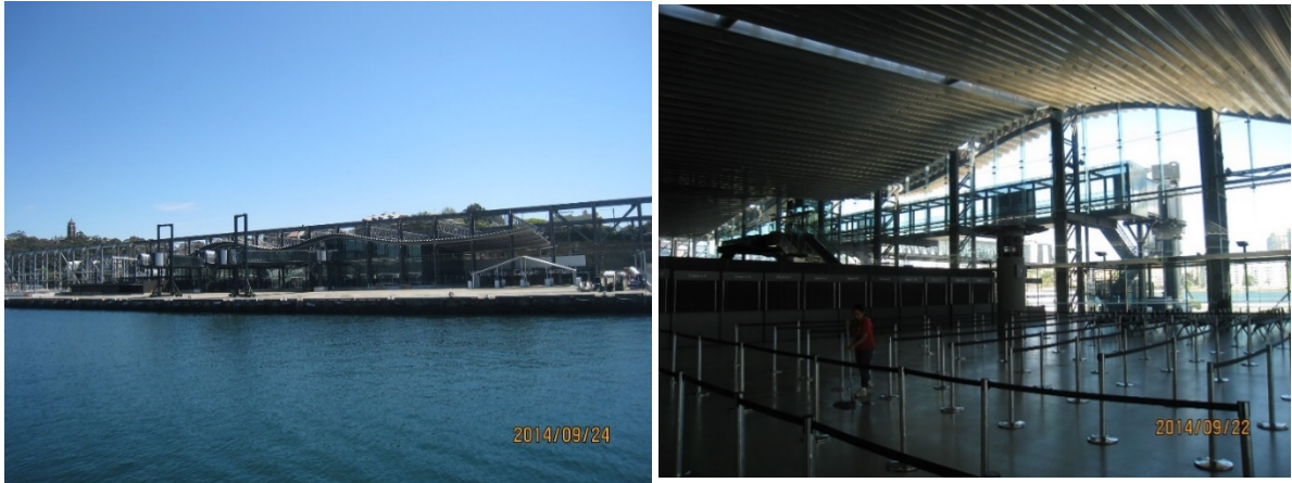
写真. 3-14 ターミナルの外観・内観（2014 年 9 月撮影）
