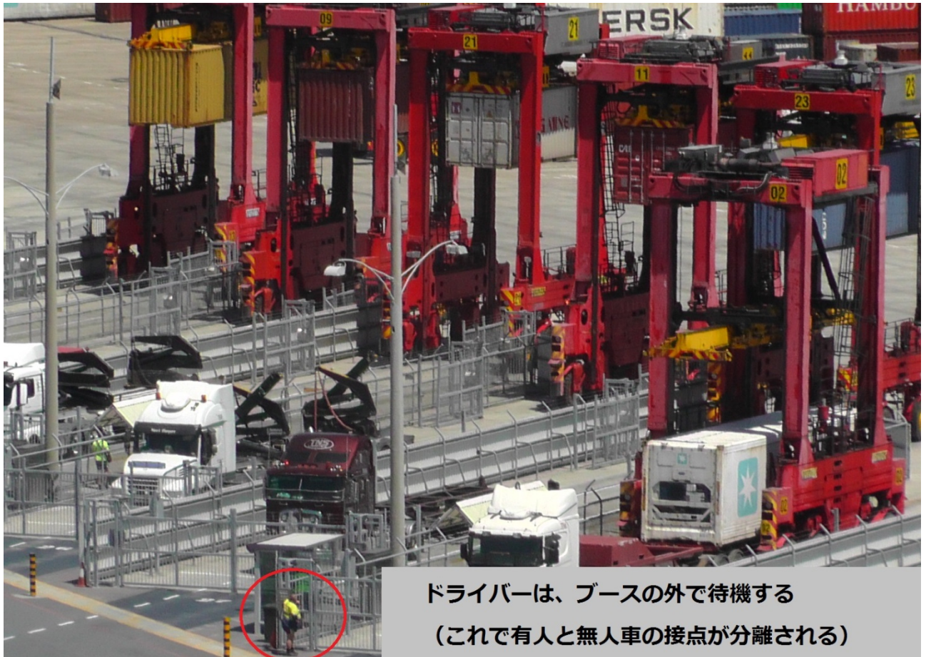
(写真—11) トラックゲートブース (有人と無人車の接点を分離)
