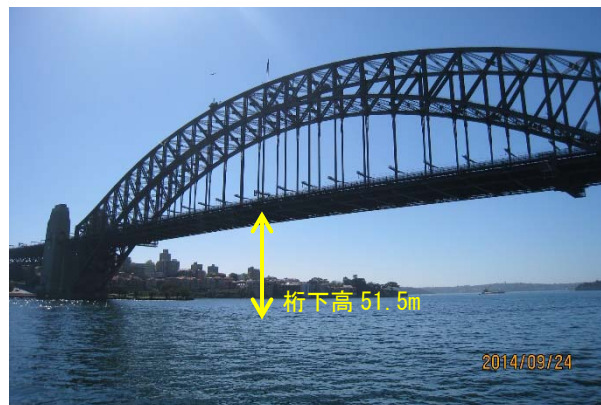
写真. 3-15 ハーバーブリッジ桁下の様子（2014 年 9 月撮影）
