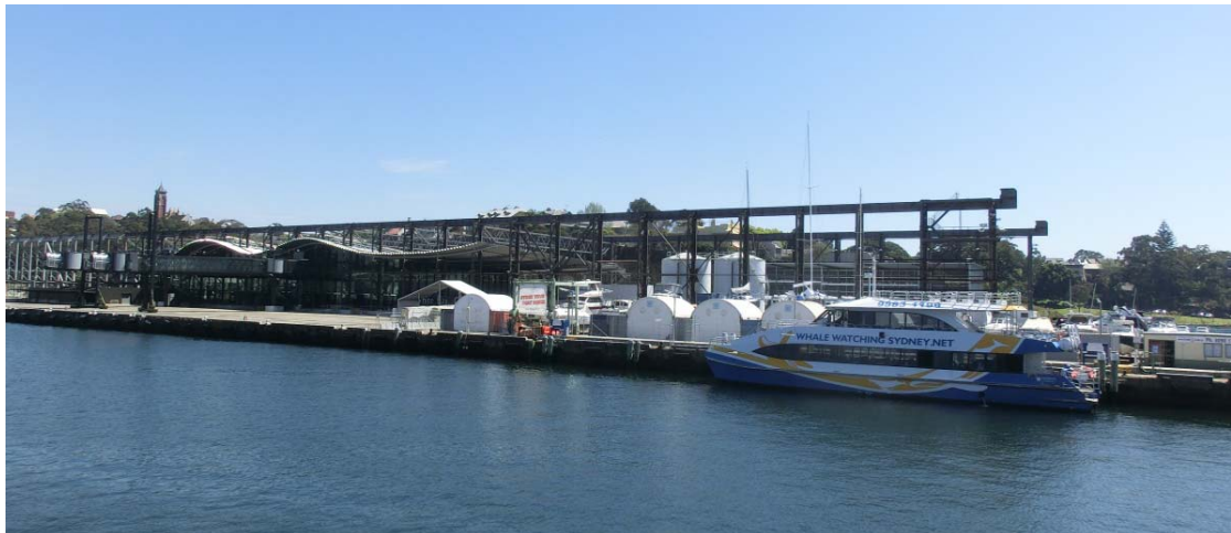
写真：ホワイト・ベイのクルーズターミナル。既存倉庫の骨組みを取り壊さずにデザインとして活かした斬新なスタイル。
