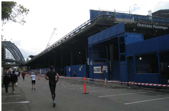
写真. 3-5 ターミナル改修工事の様子 (2014. 9. 21 撮影)
