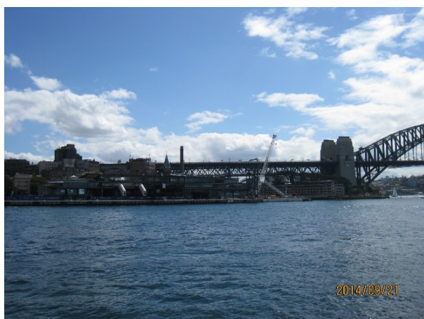
写真. 3-7 岸壁拡張工事の様子 (2014. 9. 21 撮影)
