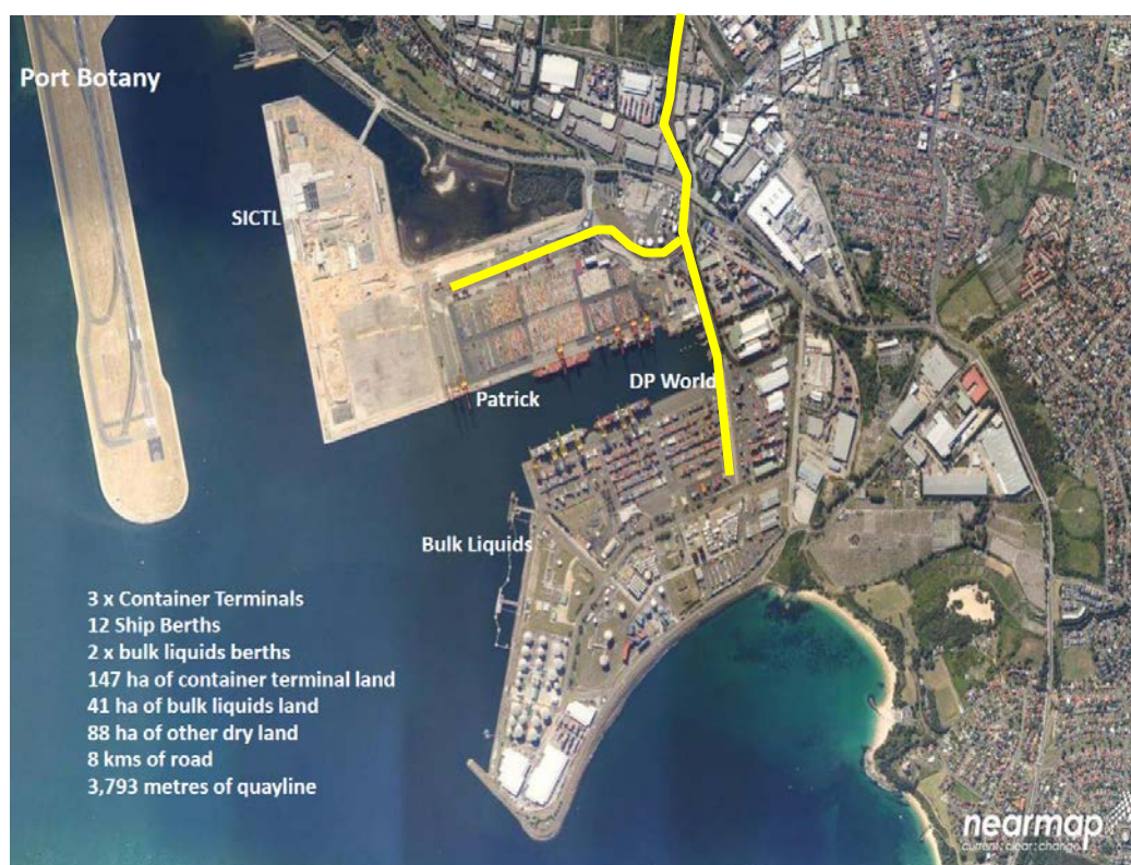
写真 7. 貨物鉄道ターミナル引き込み線（黄色線） （現在は SICTL にも引き込み線が延伸している）
