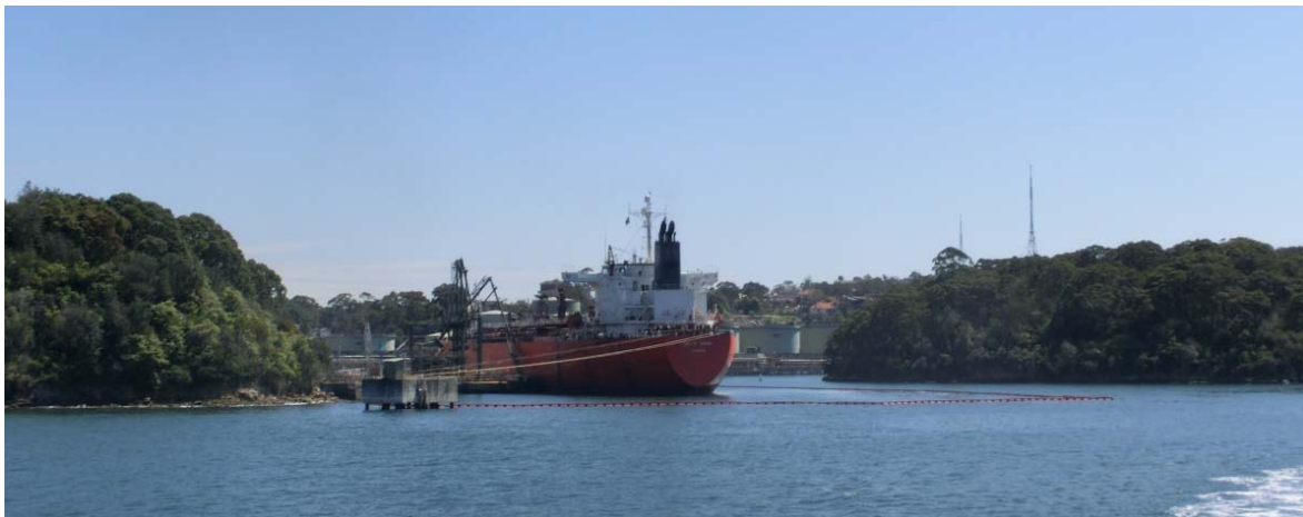
写真：ゴア・カーブの液体バルクターミナル。シェル石油が専用使用。
