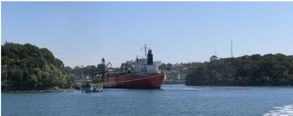
写真：ゴア・カーブの液体バルクターミナル。シェル石油が専用使用。
