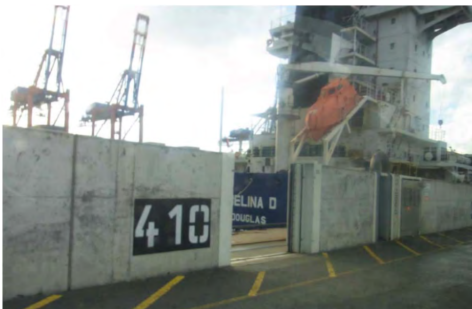
図-2 CTA (Container Terminal Altenwerder) ターミナル内の防潮壁
