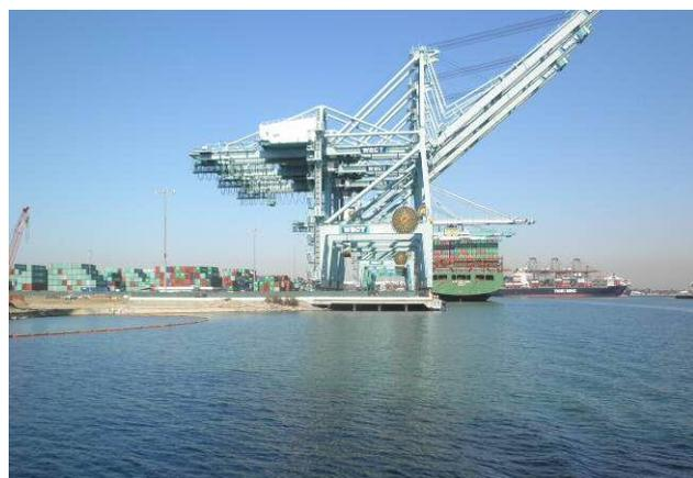
簡易な石積護岸（写真左）と栈橋形式の岸壁（写真右）
