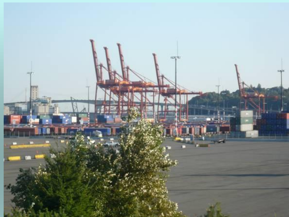
ターミナル5のガントリークレーン (撮影: H24.10.5)
