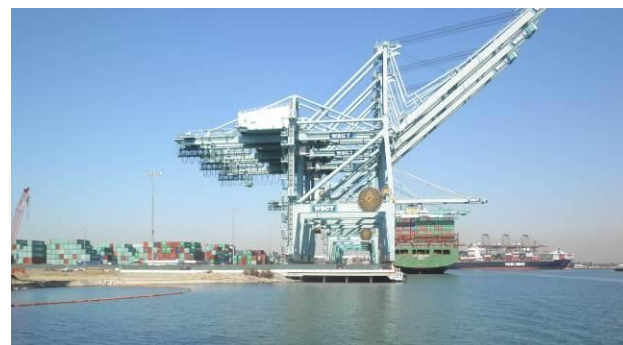
石積護岸とその前面の岸壁（棧橋形式）
